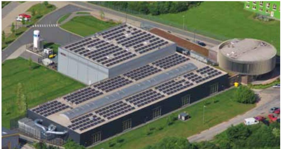
Elektronikproduktion und PV-Anlage auf dem Dach mit einer Gesamtleistung von 111,8 KWP und einem Eigenverbrauch von 60 %
