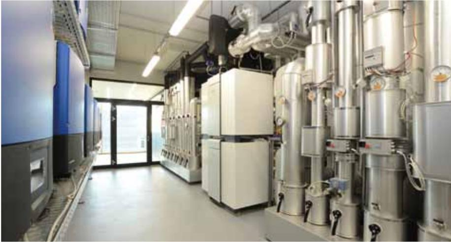
Technikzentrale mit Wärmepumpen und Hydraulik
