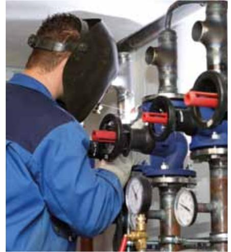
Aufbau eines Heizungsverteilers
